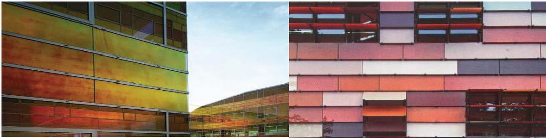
Figura 21. Fachada de edificios con vidrios de color no reflectantes. Fuente: Pirmin Nietlisbach, *Construir con cristal y luz sin perjuicio para las aves. Estación Ornitológica Suiza, Sempach.*
